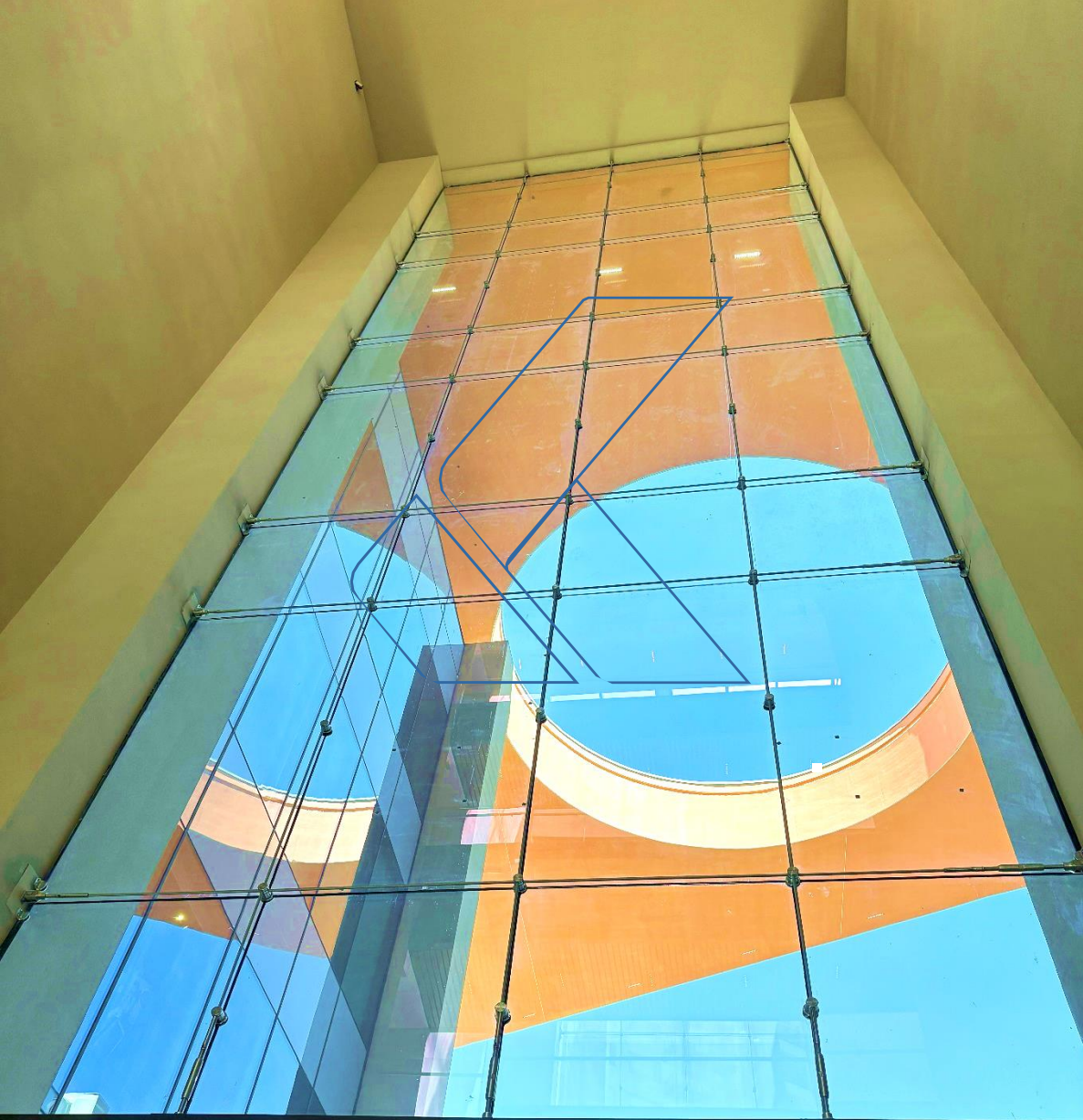
Fratra Center Puebla Fachadas de Acceso, Posterior y Laterales Clamps con Cabletek Horizontal y Vertical Instalador : Construcciones CASALA Puebla, Puebla
