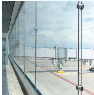
SISTEMA DE CLAMPS CON CABLETEK
